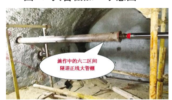
图三 大管棚加工示意图
